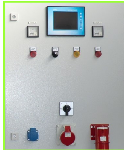
Schaltanlage bis 12 kW mit schaltbarer Notsteuerung und Notstromversorgungsanschluss
